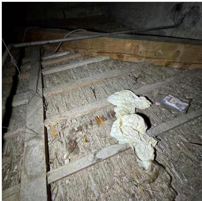
COMBLES 4 : infiltrations faibles, défauts d'étanchéité
