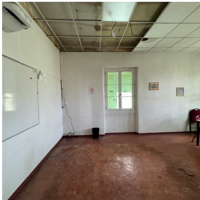
SALLE DE REUNION EST: infiltrations importantes avec destruction du faux-plafond contemporain.
