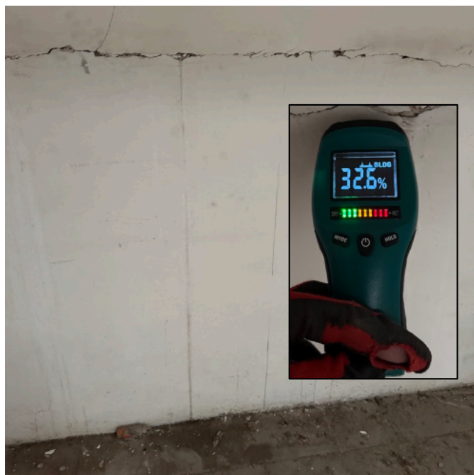
LOCAL 3 : infiltrations modérées qui s'écoulent sur la cloison présentant un fort taux d'humidité.
