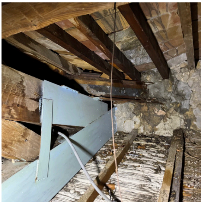
COMBLES 4/5 : infiltrations fortes qui continuent à dégrader la charpente
