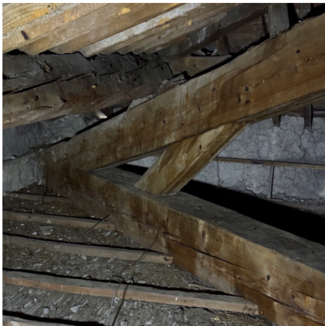
COMBLES 4 : infiltrations faibles, défauts d'étanchéité au niveau de l'arrête en couverture
