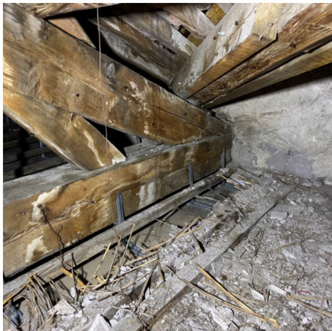
COMBLES 5/6 : infiltrations modérées au niveau de la noue Nord de la lucarne en pignon.
