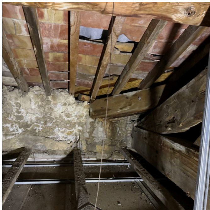
COMBLES 5/6 : infiltrations faibles à modérées malgré les réparation faites en couverture.
