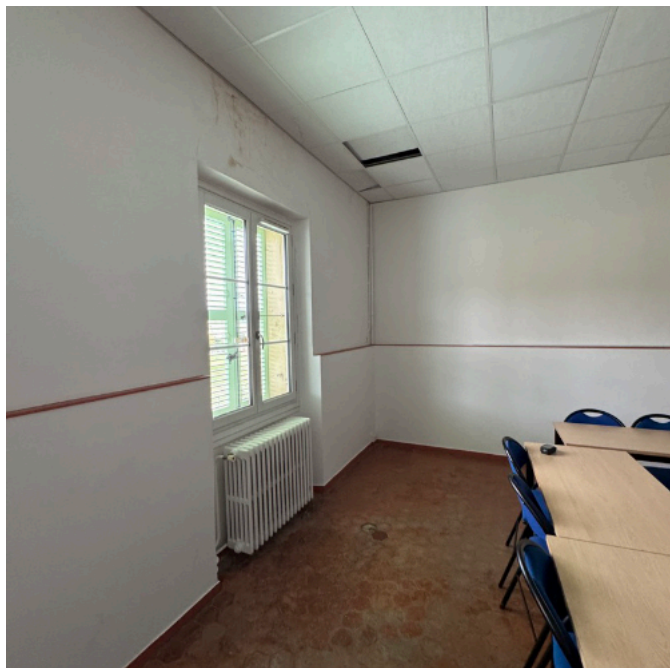
SALLE 1 : infiltrations récentes faibles, anciennes traces.
