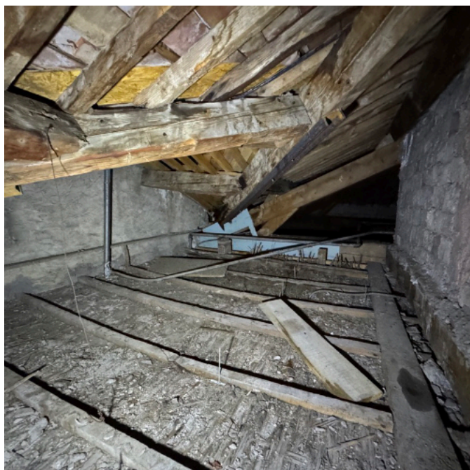
COMBLES 5 : infiltrations modérées au faîtage de la lucarne, au droit de la cloison séparative avec le local 3.
