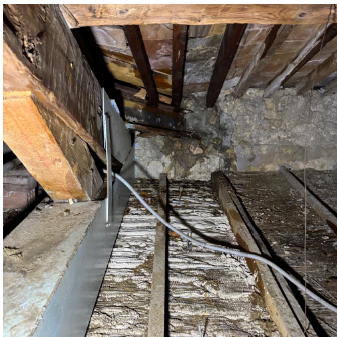
COMBLES 4/5 : infiltrations fortes au niveau de la noue Sud de la lucarne en pignon.
